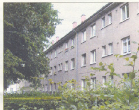
Streng funktionale Architektur in einer Grünanlage mit altem Baumbestand; die Friedrich-Ebert-Siedlung ist eine typische Vertreterin ihrer Zeit.
