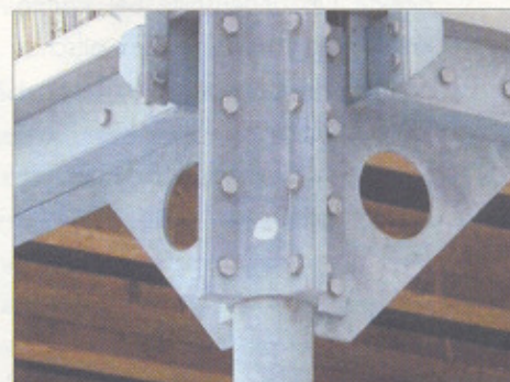
Auch im Detail durchdacht: Neue Balkone, wärmebrückenfrei vor die sanierte Fassade gestellt.
