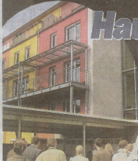
Ansprechende Fassade, innen modernste Technik: Das Passivhaus in der Gropiusstraße
