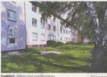
Frankfurt: Altbau nach Passivhaus. Foto: GAG
