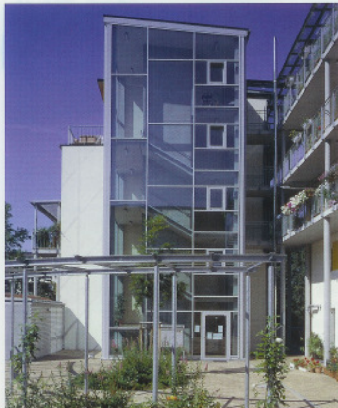
St. Jakob: Das erste in Frankfurt am Main realisierte Passivhausprojekt
