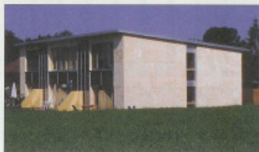
Abb. 2: Das Reihenhaus mit drei Wohneinheiten (insgesamt 370 \text{ m}^2 Wohnfläche) in Hörbranz/Vorarlberg ist ein Massivbau mit Ziegelmauerwerk und 35-cm-Kork-Wärmedämmverbundsystem.
