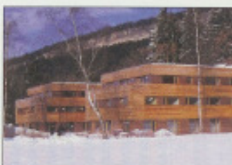
Abb. 4: In Wolfurt/Vorarlberg entstanden zwei identische Mehrfamilien-Passivhäuser, die über eine Pelletheizung und eine 43-m 2 -Kollektoranlage mit Wärme und Warmwasser versorgt werden.
