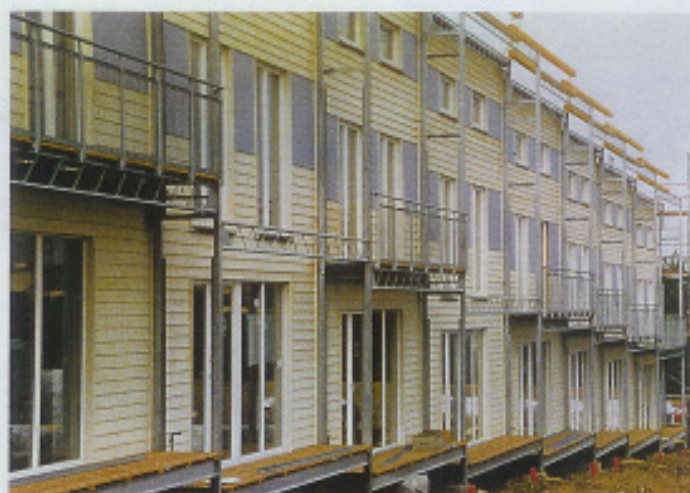
Balkone und Terrassen werden nachträglich vor die Süd-Fassade gesetzt.
